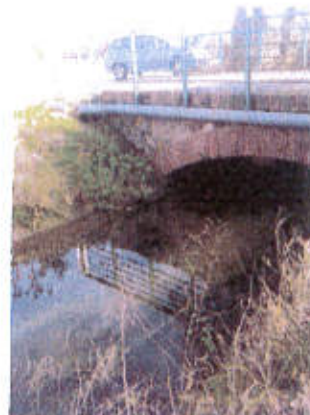
canal de Pézilla (exutoire principal)
